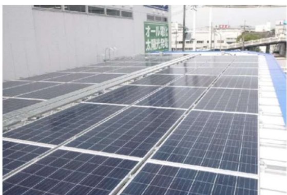
寝屋川工事所屋上
